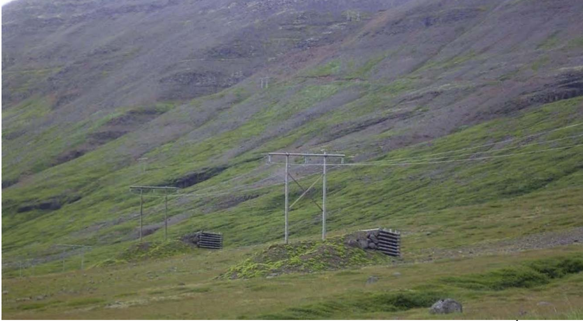
Mynd 28. Snjóflóðavarnir við staura utan við fyrirætlaðan gangamunna í Arnarfirði. Í bakgrunni má sjá móta fyrir raflínustaurum yfir fjallið sem verða fjarlægðir þegar raflínustrengur verður lagður í göngin. Mynd Kristjana Einarsdóttir 2009.
