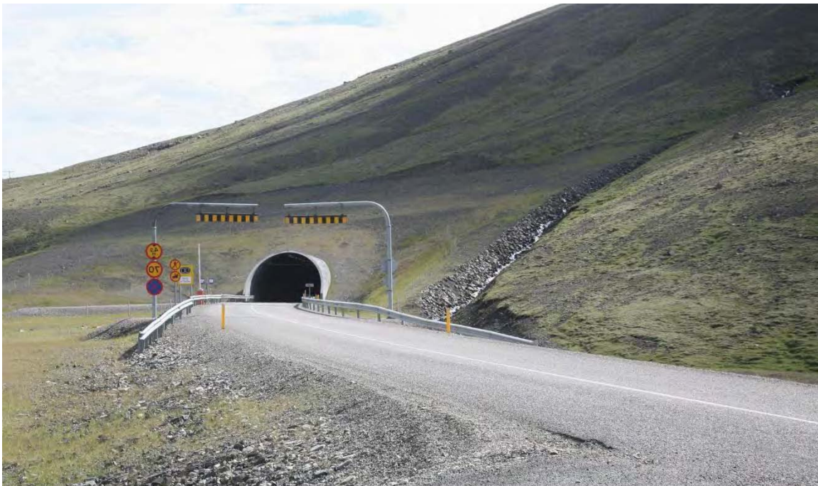
Mynd 13. Spegluð mynd af gangamunna Almanskardís. Munninn Dýrafjarðarmegin mun koma í svipaðri beygju út úr fjallinu en á hærri fyllingu. Mynd Ágúst Guðmundsson.
