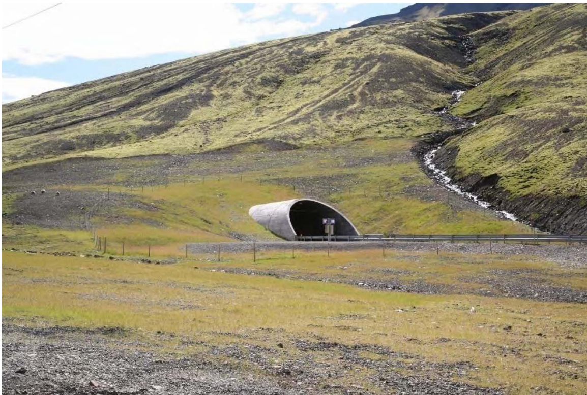
Mynd 15. Séð á hlið vegskálans í Almannaskarði. Myndin er spegluð svo munninn snúi í sömu átt og munn Dýrafjarðarganga. Munninn Dýrafjarðarmegin mun koma í svipaðri beygju út úr fjallinu. Mynd Ágúst Guðmundsson.
